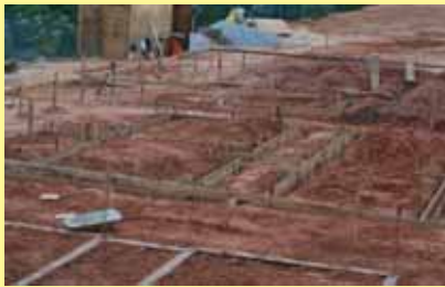
INÍCIO DAS OBRAS 12/2009
